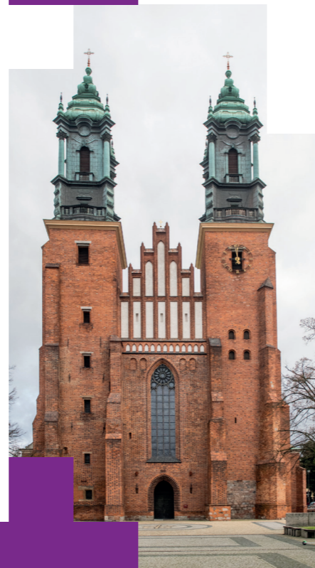
Fot. / Photo Ł. Gdak
